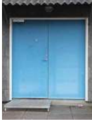
14. Plan glat dør. Dør med plan plade påsat. Enkel dørtype, der kan være kombineret med et lille (runt) vindue, der kendes tilbage til modernismens bygninger fra 1930'erne.
