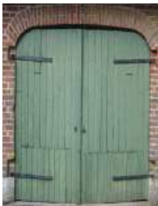
7. Revleport. Port fremstillet af sammennotede brædder, der har to vandrette revler og en skrårevle på bagsiden. Finere revleporte kan være beklædt med et lag brædder på ydersiden.
