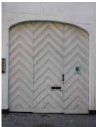
8. Flammeret port. En revleport pålagt en beklædning af profilerede brædder, anbragt på skrå og skåret sammen i et rudemønster, kvadrater, zig-zag eller sparrer (omvendte V'er).
